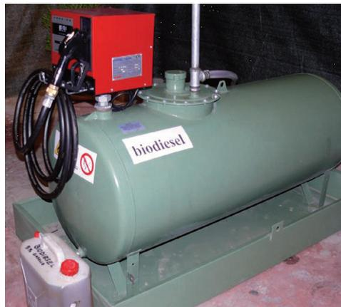
Foto 5 - Serbatoio per biodiesel.
