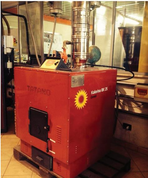
**Foto 3** - Kalarina BK25-Potenza Nominale 29 kW, modulazione percentuale della potenza da 9 a 20 kW
